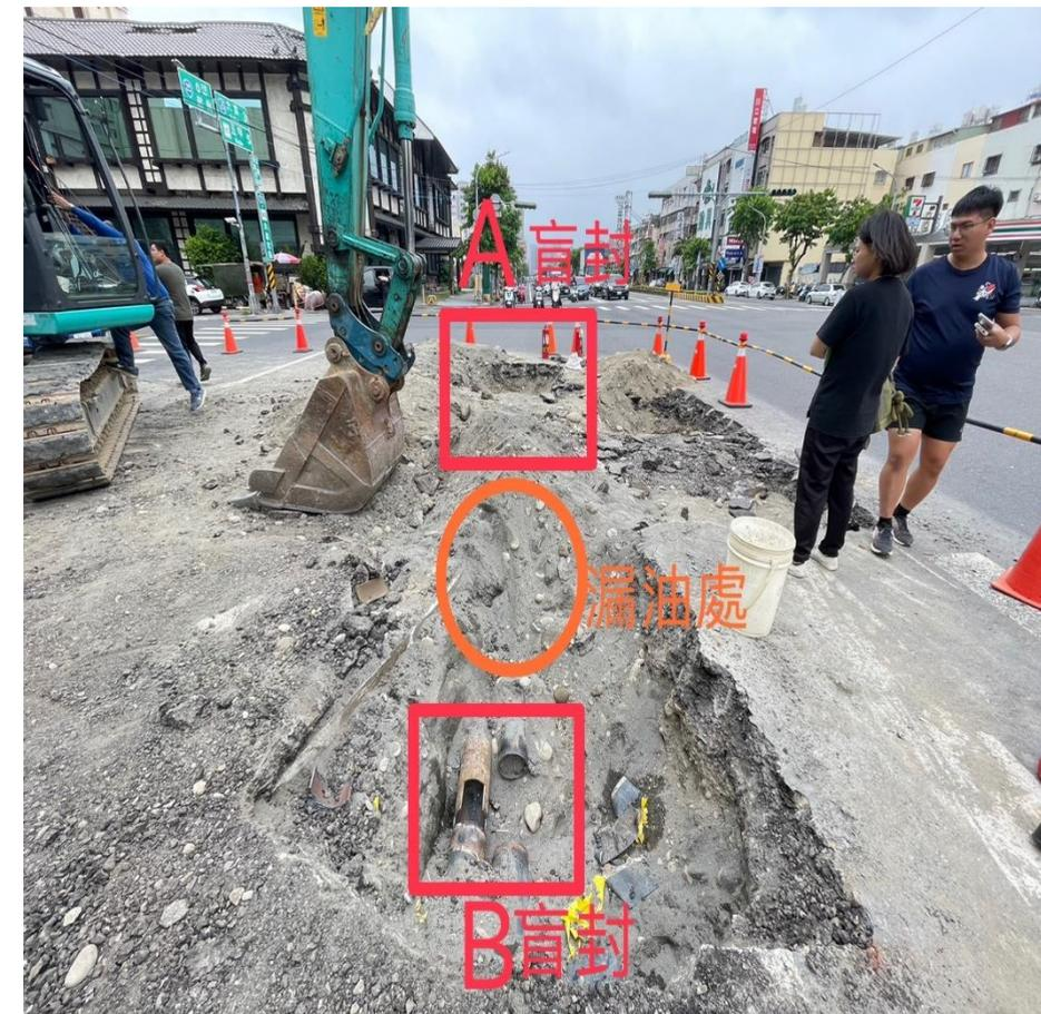
112/10/04盲封作業，因颱風來臨先行回填，擇日再進行接管作業。
