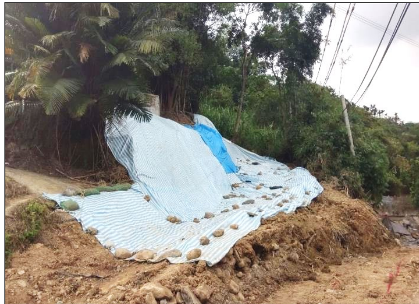
鋼軌樁打設完成並覆蓋帆布
