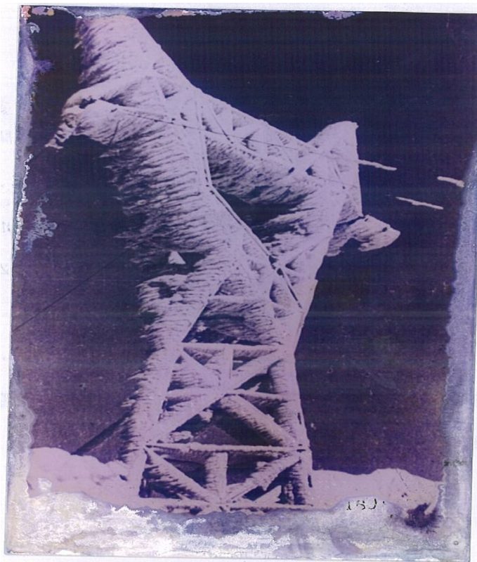
69kV萬大~銅門線
