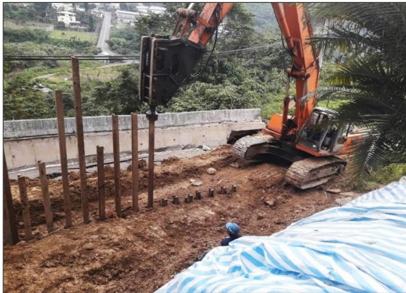
鋼軌樁打設
