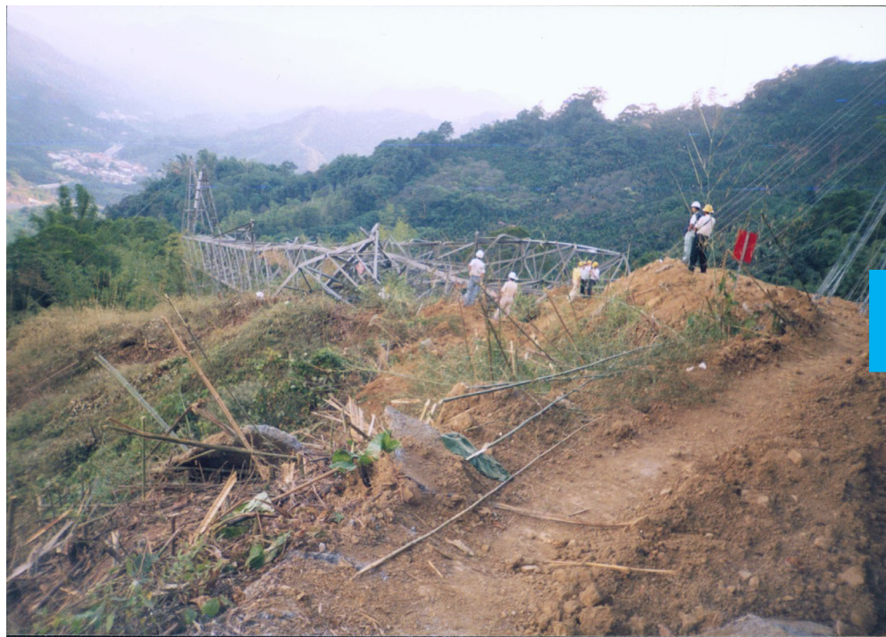
921地震造成峨眉~中寮線#203倒塌
