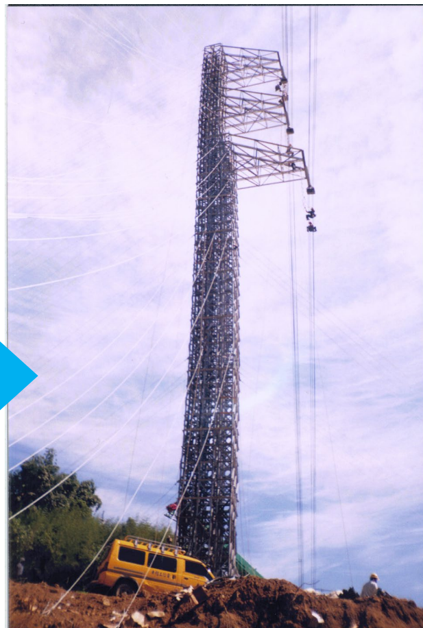
興建臨時角鋼桿緊急供電
