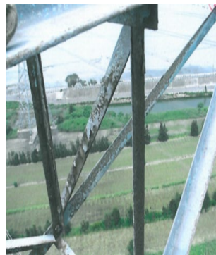
導、地線、鐵塔構材鏽蝕嚴重
