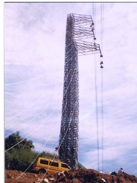
興建臨時角鋼桿緊急供電
