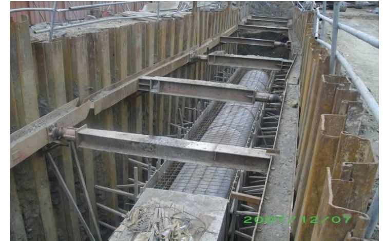
明挖埋管~鋼板樁擋土
