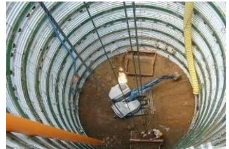
推管工法~鋼襯鉸工作井
