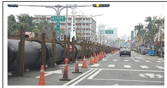
於崑山路鋪設明管復水
