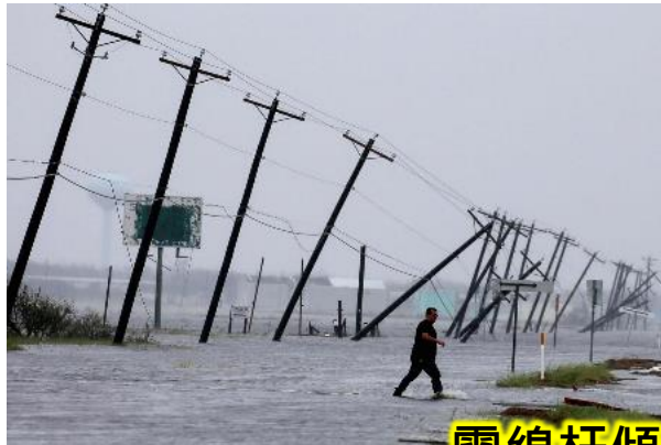
電線杆傾倒毀損
