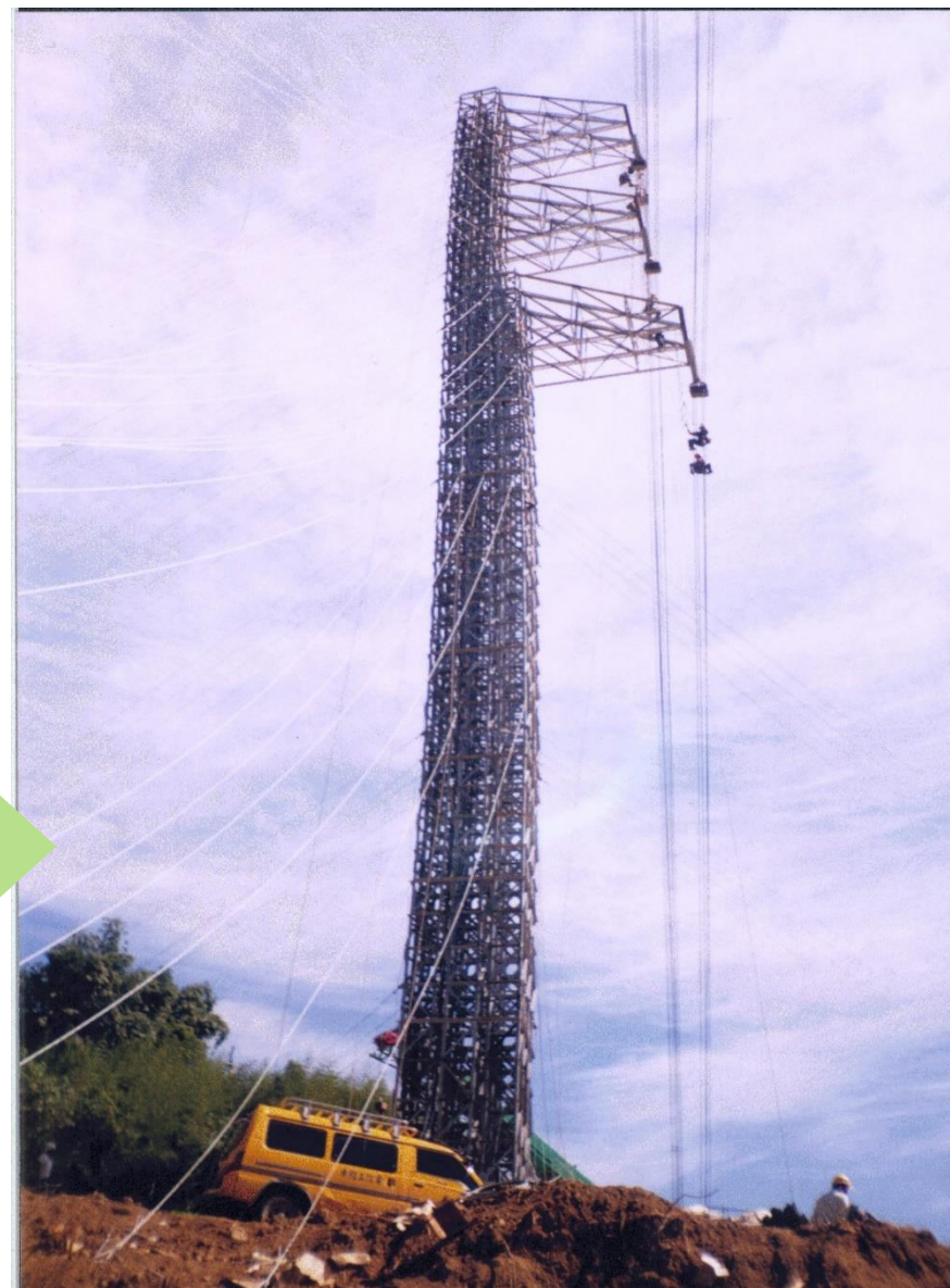
興建臨時角鋼桿緊急供電
