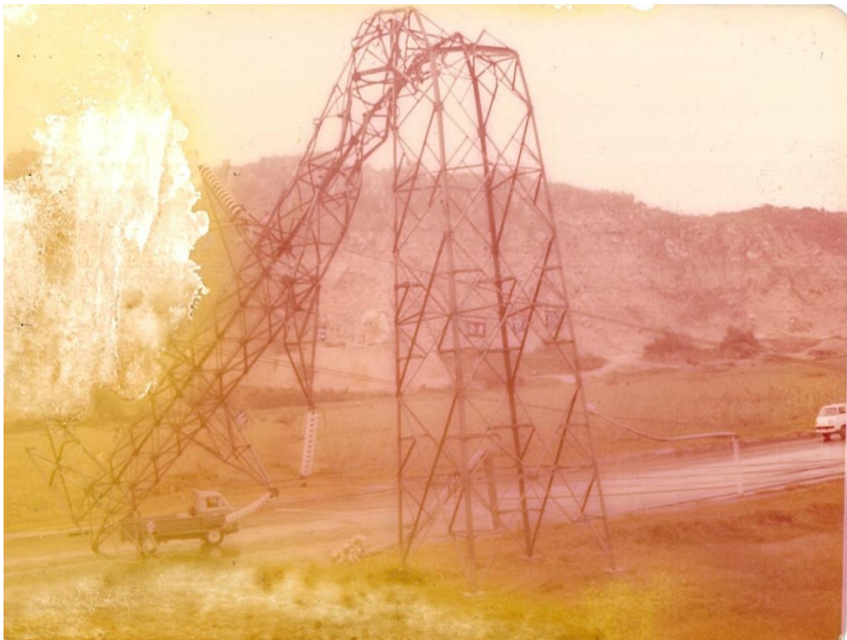
賽洛瑪颱風 大林-南工線#36鐵塔倒塌
