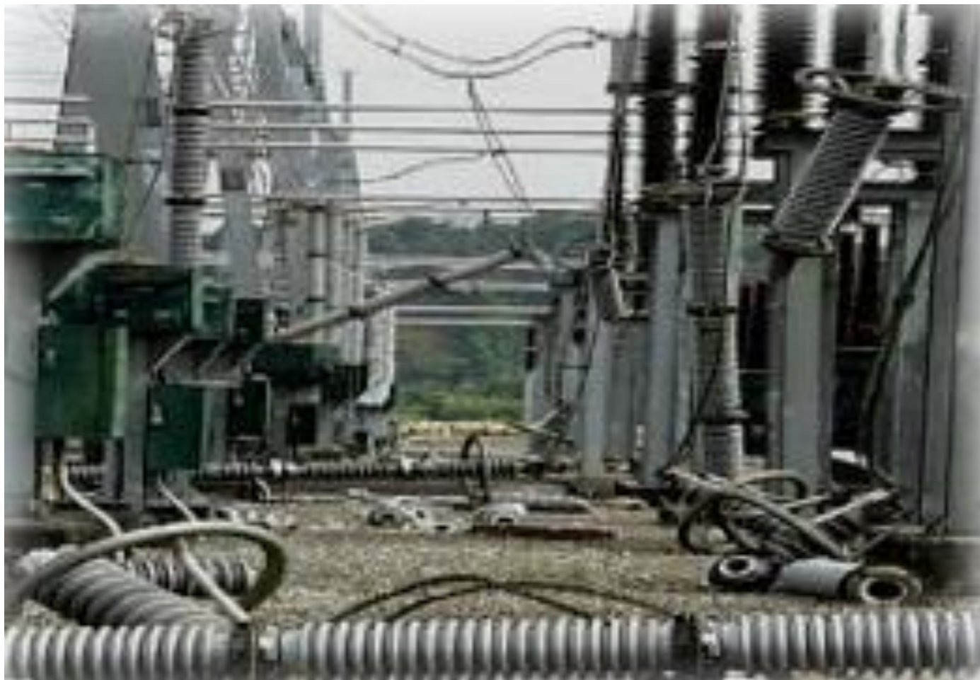
921地震重創變電設備(中寮變電所)
