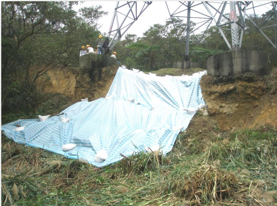
塔基崩塌先覆蓋帆布以 防崩塌面積擴大
