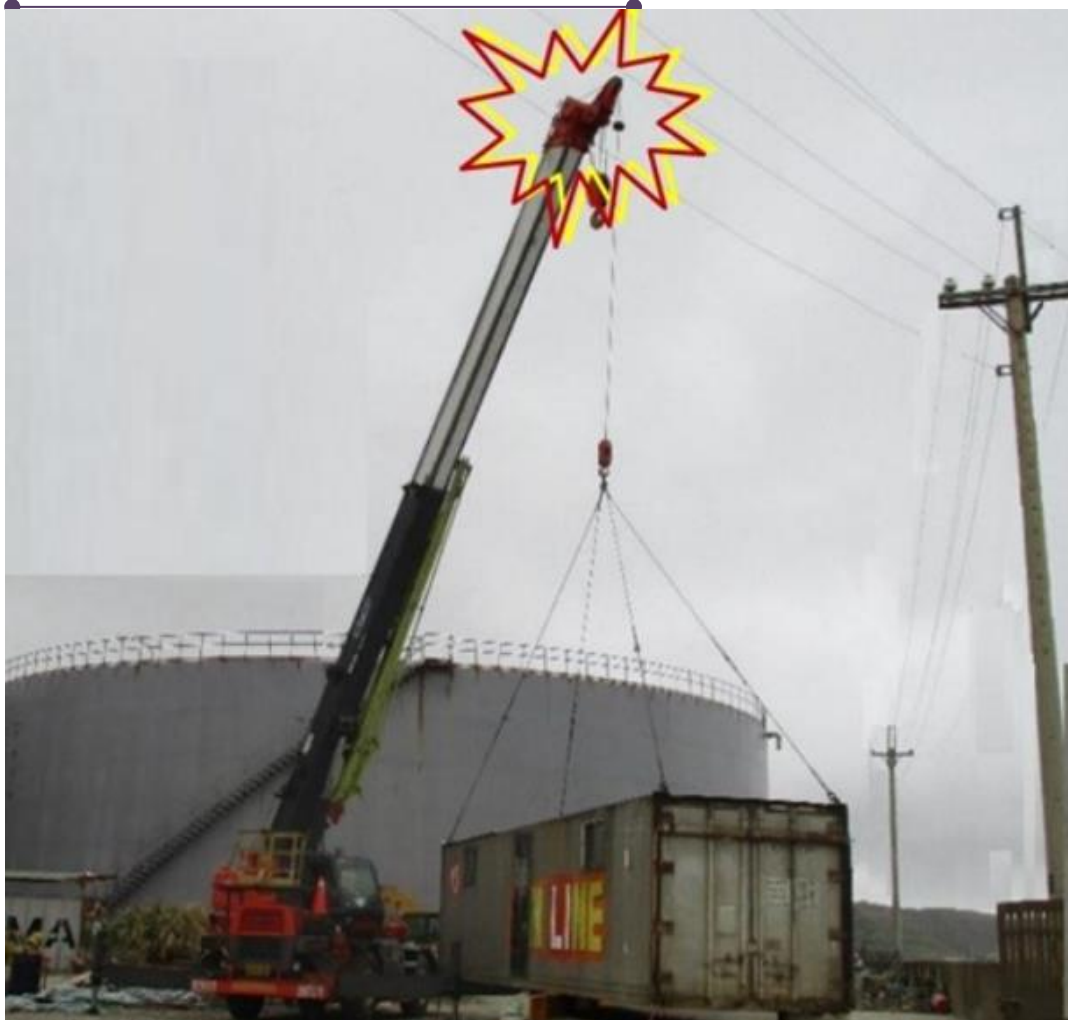
線下吊掛物品誤碰輸電線
