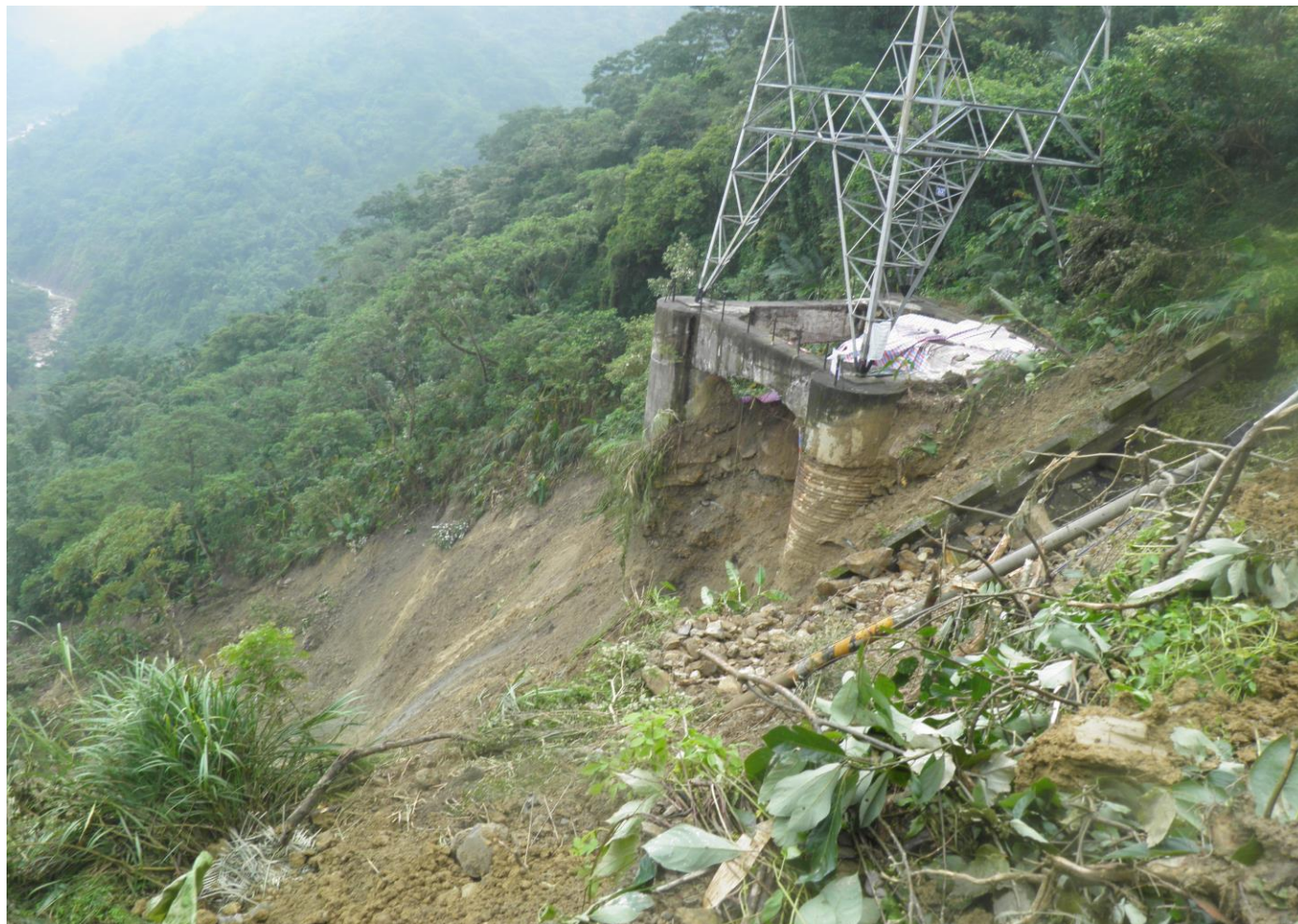
345kV大觀中寮一、二路14塔基坍方
