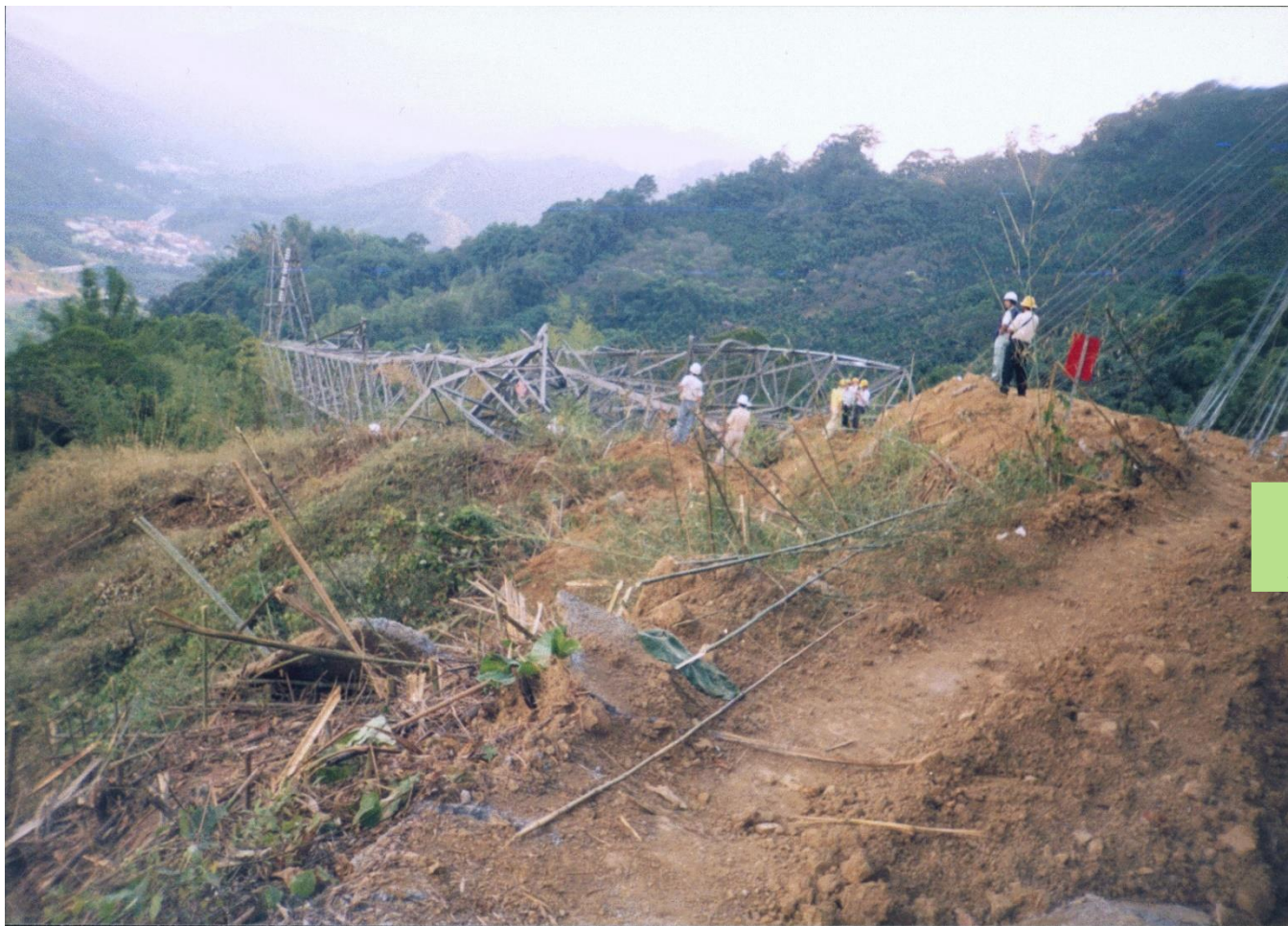
921地震造成峨眉~中寮線#203倒塌
