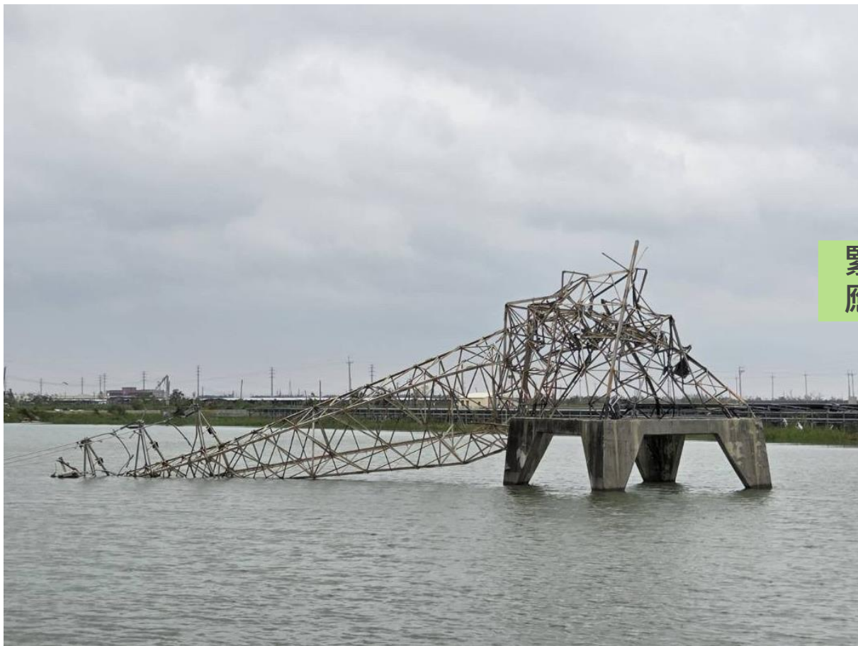
2025丹娜斯颱風 造成新塹 - 永華線#2、#3、#4號輸電鐵塔倒塌
